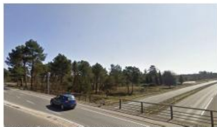
Echangeur de l'A62 et la RD 1113, comme porte d'entrée Sud
